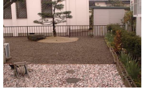
<GP工法 施工後>
