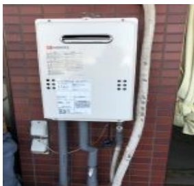
<給湯器など エコキュート取替工事>
